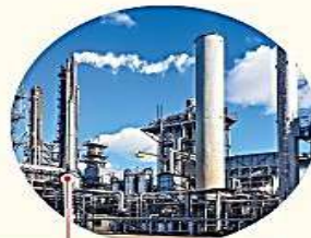
Stabilimento per la produzione di ammoniaca in un impianto petrolchimico.
