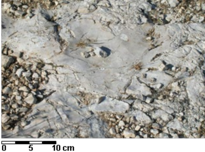
Test 1 - Calcari visibilmente fratturati
