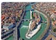
A Veduta aerea del "colle Tiberino", lungo il ponte di 200 m di lunghezza per 10 m.
